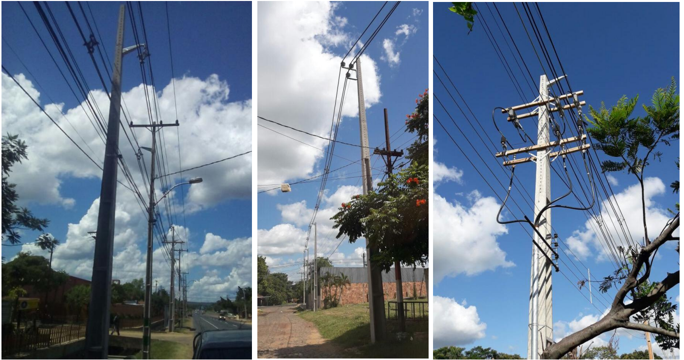
Construcción de nuevo alimentador de MT ITG 08 desde el Centro de Distribución Itauguá. Licitación Pública Nacional ANDE N° 1312/2017 – BONOS II
