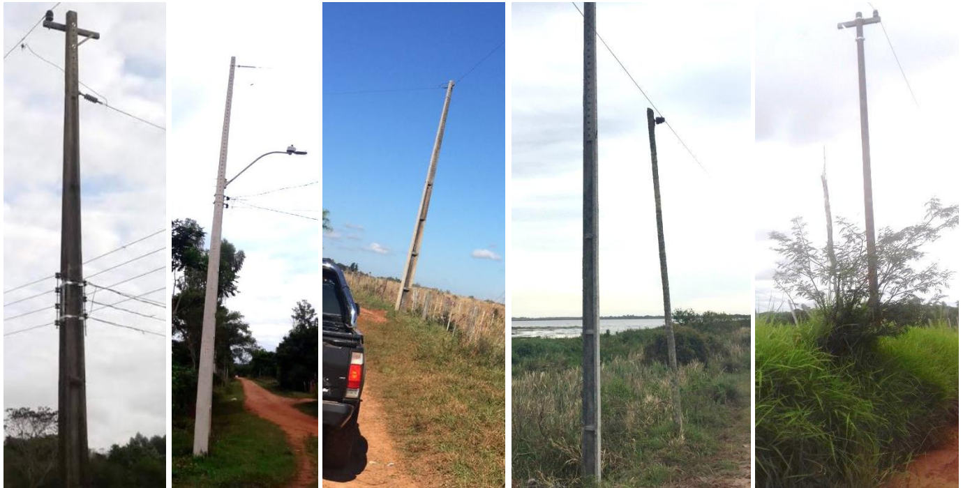
Ejecución de trabajos de normalización de líneas de autoayuda en MT y BT, en los Dptos. de Guairá, Misiones y Paraguarí – Licitación Pública Nacional ANDE N° 1169/2015 - Lotes 1, 2, 3, 4 v 5 - BONOS II
