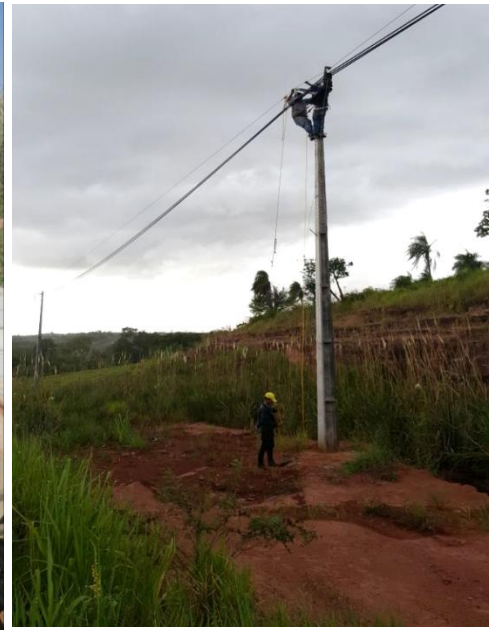
Construcción de Nuevos Alimentadores de Media Tensión emergentes del Centro de Distribución Curuguay II, en el Distrito de Curuguay, Departamento de Canindeyú- Licitación Pública Nacional ANDE N° 1221/2016 – BONOS I
