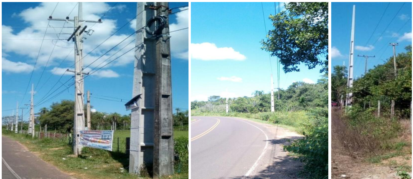
Construcción e interconexión de la Subestación Altos en 220 KV. Construcción de Obras de Distribución, incluyendo el suministro de materiales. Licitación Pública Nacional ANDE N° 1203/2016 - Lote 2 – BONOS II
